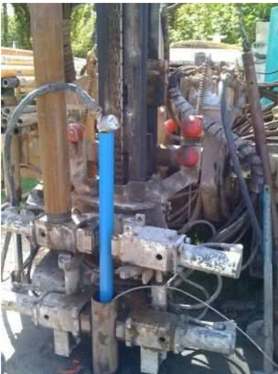
Figure 13 : Déroulement d'un essai d'injection
